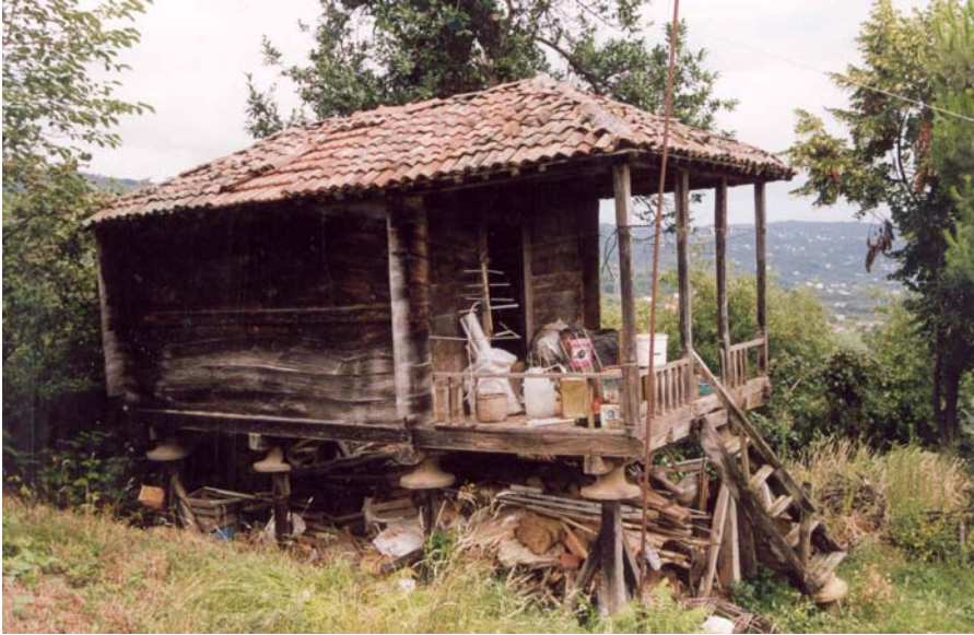
Fotoğraf 3: Okağaçlı, omuz çatılı, taraklama duvarlı,  ıkmalı serender ( amlık Mahallesi - Vakfikebir)
