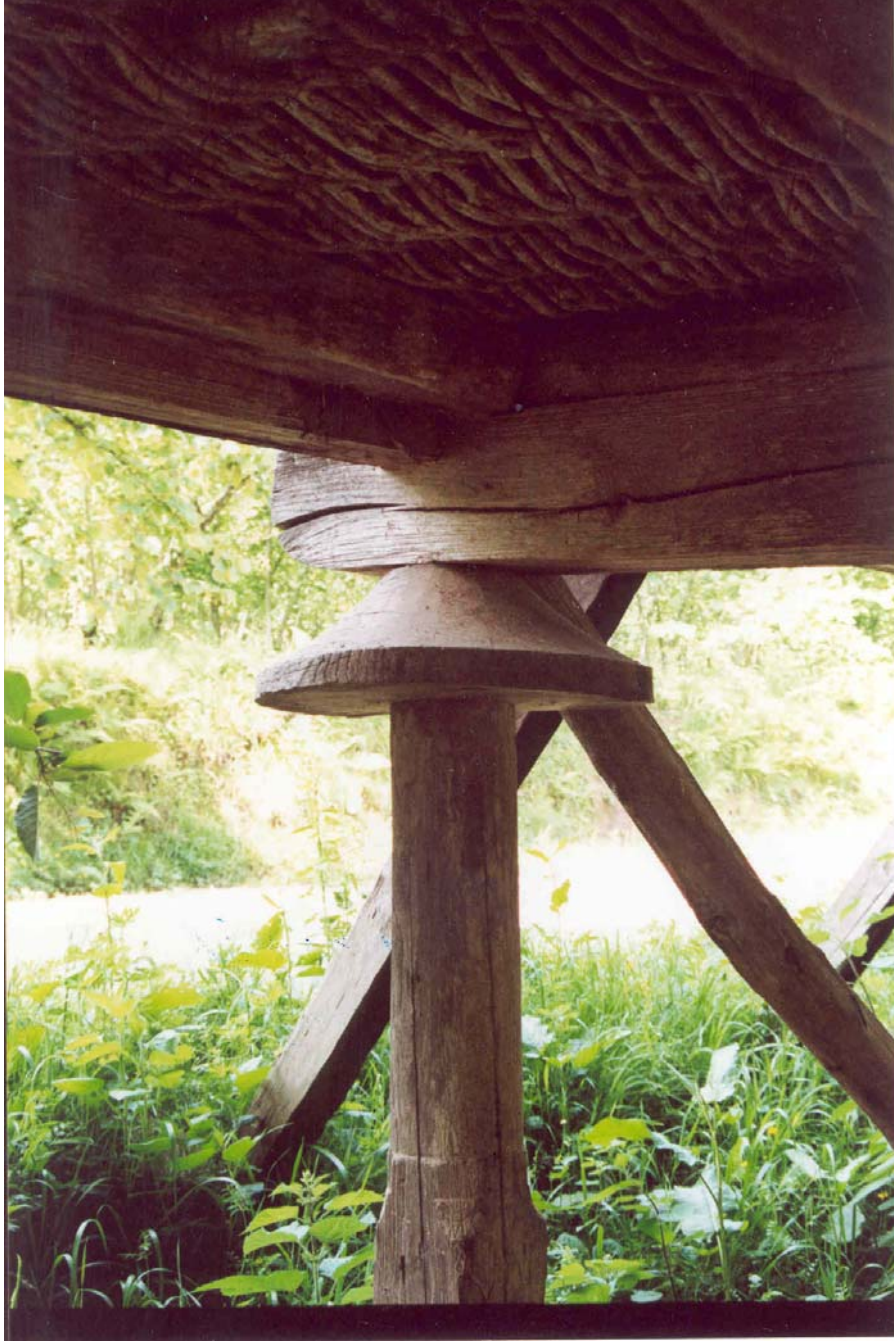
Fotođraf 9: Seren diređi, teker, uzunluk bađı, dökme ađacının birleřtirilmesi (Aksu köyü - Sürmene)
